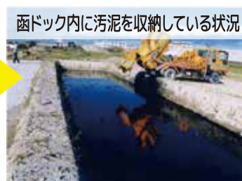
改良現場に函ドックを設置し、排水路の汚泥を集める
