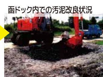
固化材を投入し、ドック内で汚泥を改良する。バックホウなど、一般的な重機で対応可能。
