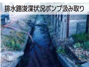
排水路に堆積した汚泥をバキューム車で汲み取っている状況
